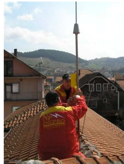
POVEZANI SPUSTNI VODOVI
